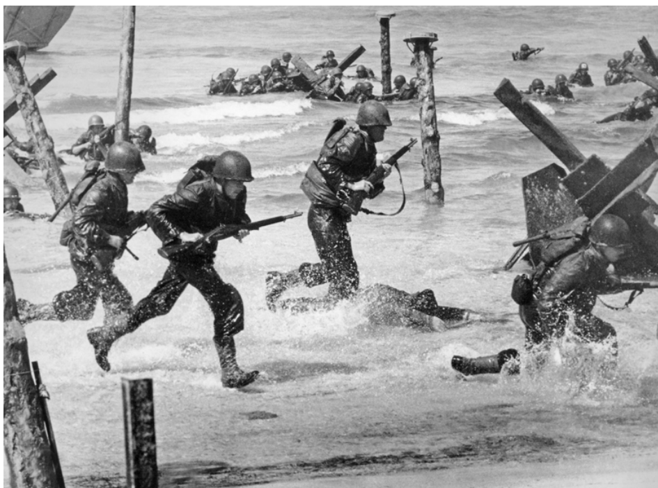
Foto: Blotlagte 'asparges' og tjekkiske pindsvin. Bemærk panserminerne på toppen af pælene.
