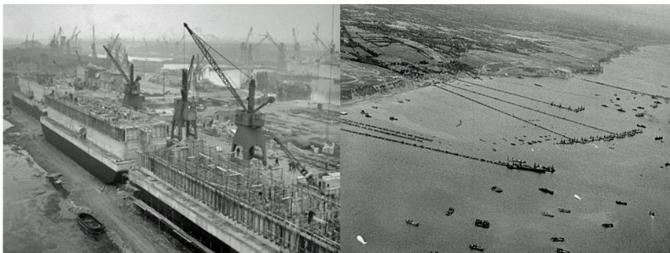
Foto: Konstruktion af Mulberry i Surry Docks i april 1944 til venstre og til højre installeret ud for Arromanches i juni. Et fantastisk stykke ingeniørkunst du kan se resterne af den dag i dag.
