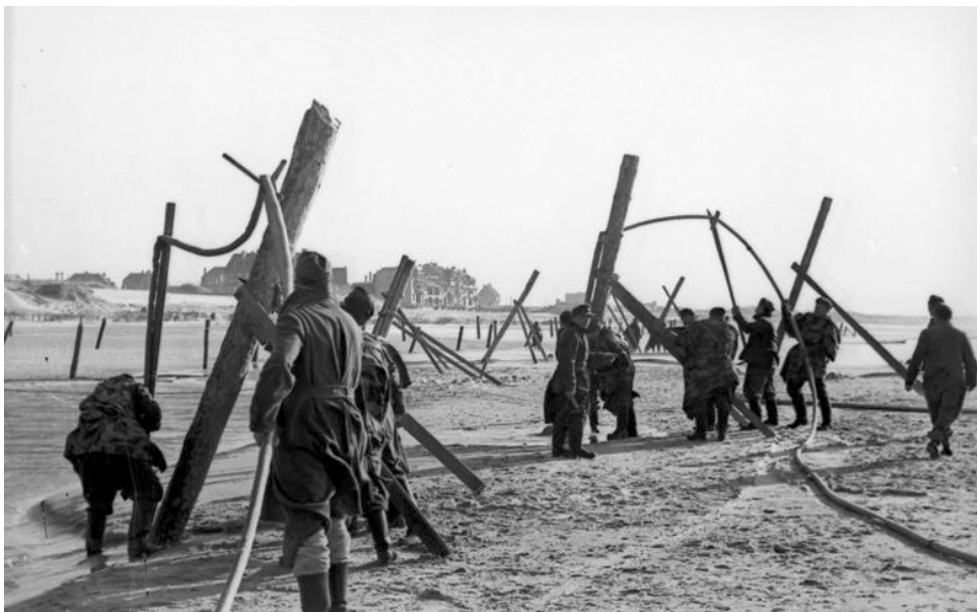
Foto: Rommel-asparges spules ned. På toppen kunne monteres en 'tallerkenmine' eller evt. en tilvirket artillerigranat. Foto: Bundesarchiv.
